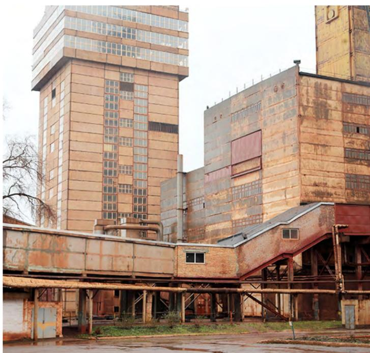
ститься под землю. На этом объекте выполнен ремонт железобетонных конструкций, частично сделаны кирпичная кладка и перекрытие. Теперь горнякам стало комфортнее там перемещаться на смену и обратно, в прошлом остались сквозняки и протекания кровли.
