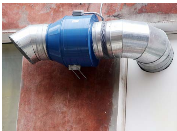
Особенно важно выделить то, что была полностью заменена система вентиляции в банных помещениях на всех трёх этажах АБК
