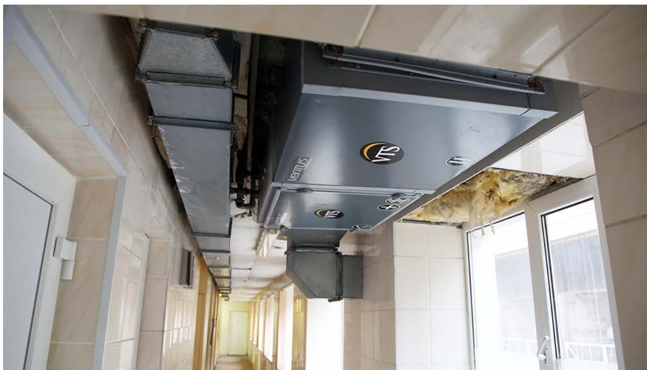
Особенно важно выделить то, что была полностью заменена система вентиляции в банных помещениях на всех трёх этажах АБК
